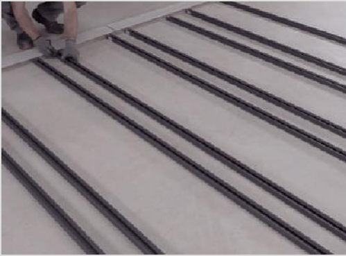
3 Cada lama debe estar apoyada sobre 4 rastreles como mínimo. Each board must be supported by at least four battens. Chaque lame doit être appuyée sur 4 traverses au minimum. Каждая планка должна поддерживаться как минимум на 4 дорожках.
