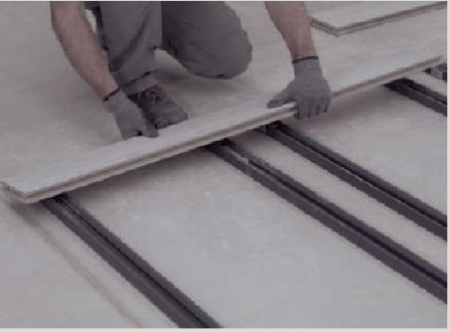
3 Instalación primera hilera de lamas. Fitting the first row of boards. Installation première rangée de lames. Установка первого ряда ламелей.
