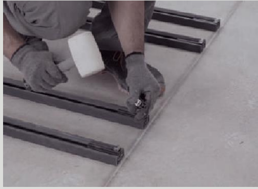
3 COLOCACIÓN DE LA GRAPA/CLIP TERMINAL MEDIANTE PRESIÓN. CLICKING IN THE END CLIP. POSE DE L'AGRAFE/CLIP TERMINAL PAR PRESSION. РАЗМЕЩЕНИЕ КЛЕМНОЙ СКОБЫ/ЗАЖИМА ПОД ДАВЛЕНИЕМ.
