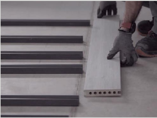
2 Usar una lama como referencia. Use a board as a reference Utiliser une lame comme référence. Используйте планку в качестве ориентира.
